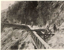
FIG. 30. BRIDGING SLIDE 4, HIGHWAY 4, CO. A.
